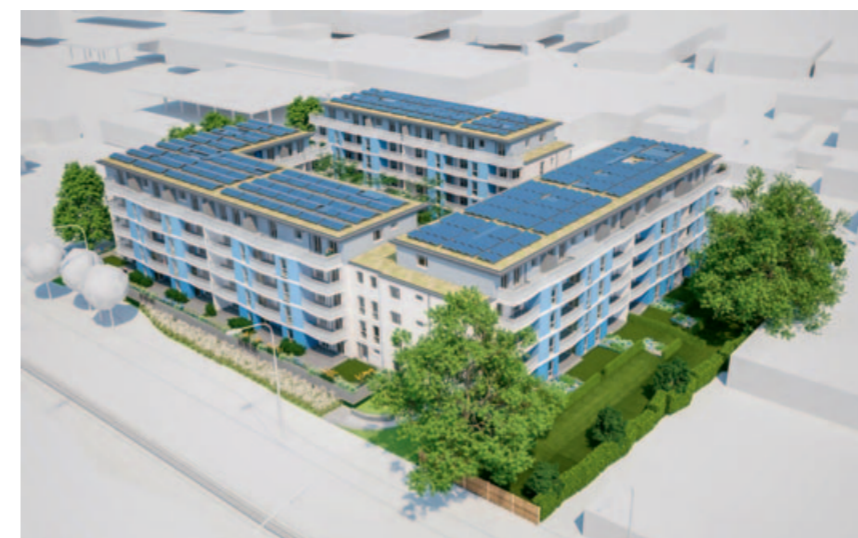
Die 7 Gebäude bestehen aus je 4 Vollgeschossen plus Staffelgeschoss – bedeckt von einem Gründach mit Photovoltaikanlage
