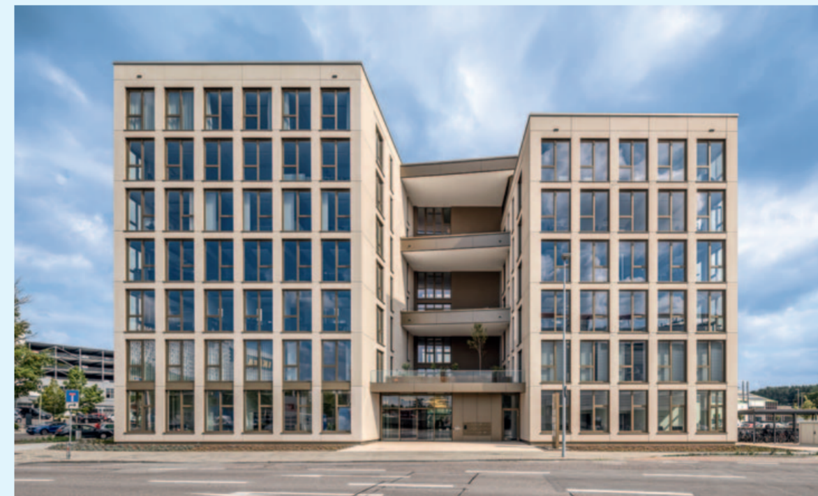
Jeder Mieter hat Zugang zu einer Terrasse oder Dachterrasse – der CarlsCube bietet mehr als 740 m² Fläche im Freien
