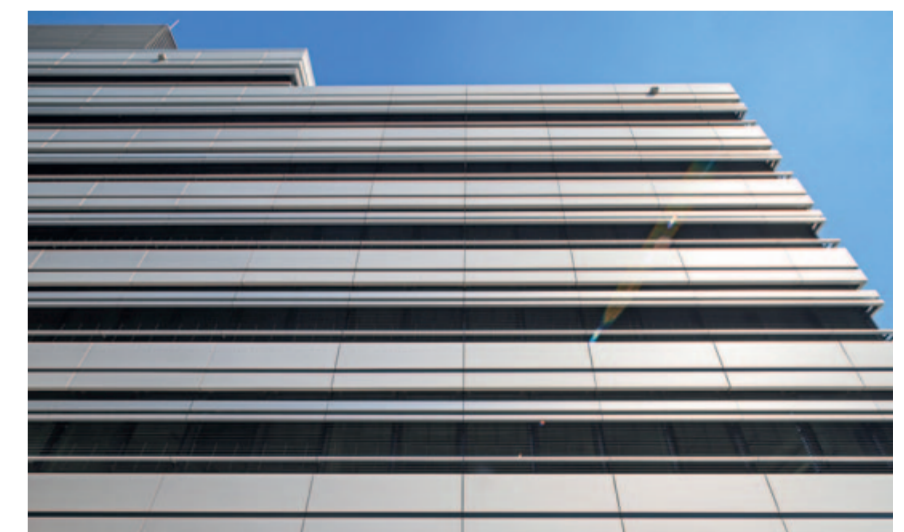
Silberfarbene Fassadenbleche umrahmen die dunkel gehaltenen Fensterbänder; horizontal verlaufende Lisenen lockern die Fassade optisch auf
