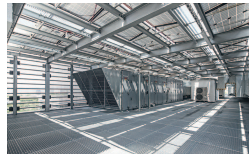
Die Technikgeschosse bestehen aus einer mit Aluminiumblech verkleideten Stahlbaukonstruktion – sie wurden mit Solarmodulen bedeckt
