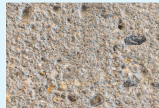
Der Beton in den Innenräumen wurde durch Stocken veredelt
