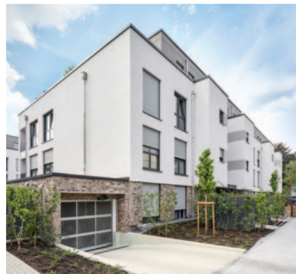
Auch die Außenanlagen gehörten zu unserem Auftrag
