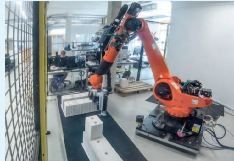
Bereits in der Testphase mauert GD-Prime selbstständig
