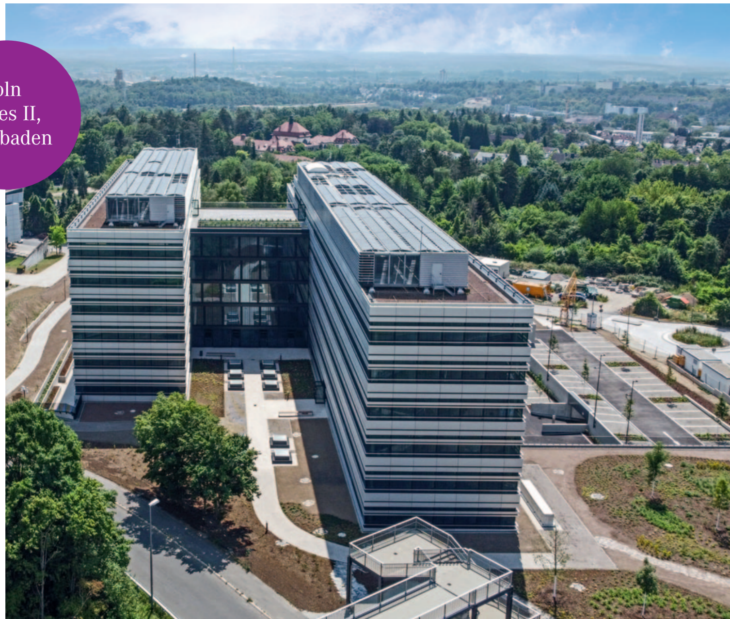
Die beiden Gebäuderiegel liegen versetzt zueinander und passen sich so an die Grundstücksfläche an, die annähernd die Form eines Parallelogramms hat
