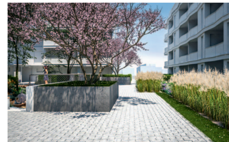
Die Bepflanzung verbessert das Mikroklima – sie wird aus unterirdischen Speichern bewässert, in denen das Regenwasser von den Dachflächen gesammelt wird
