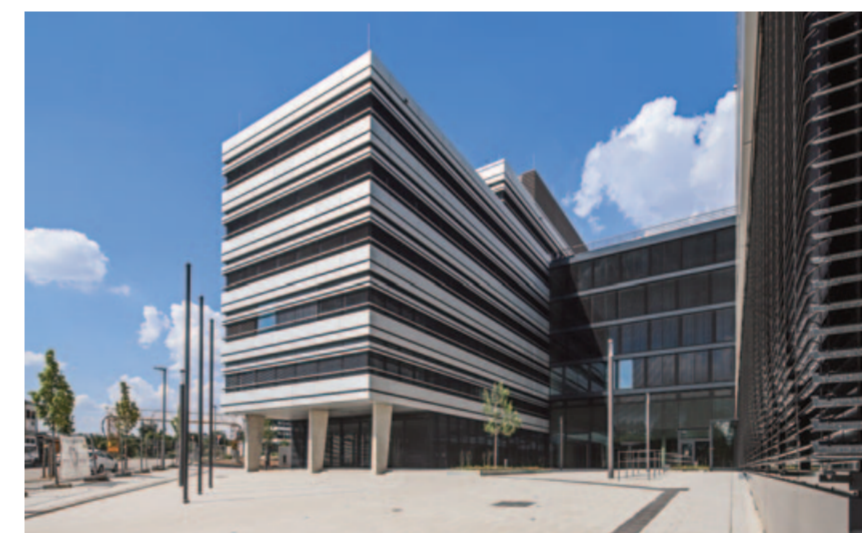
Im repräsentativen Zufahrtsbereich kommen Fertigteilstützen aus unserer Niederlassung Elemente & Industriebau – Produktion „zum Tragen“
